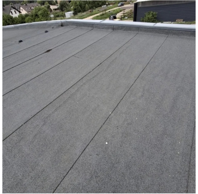
Zdjęcia nr 1 i 2 Widok dachu - nieprawidłowo ułożona papa
